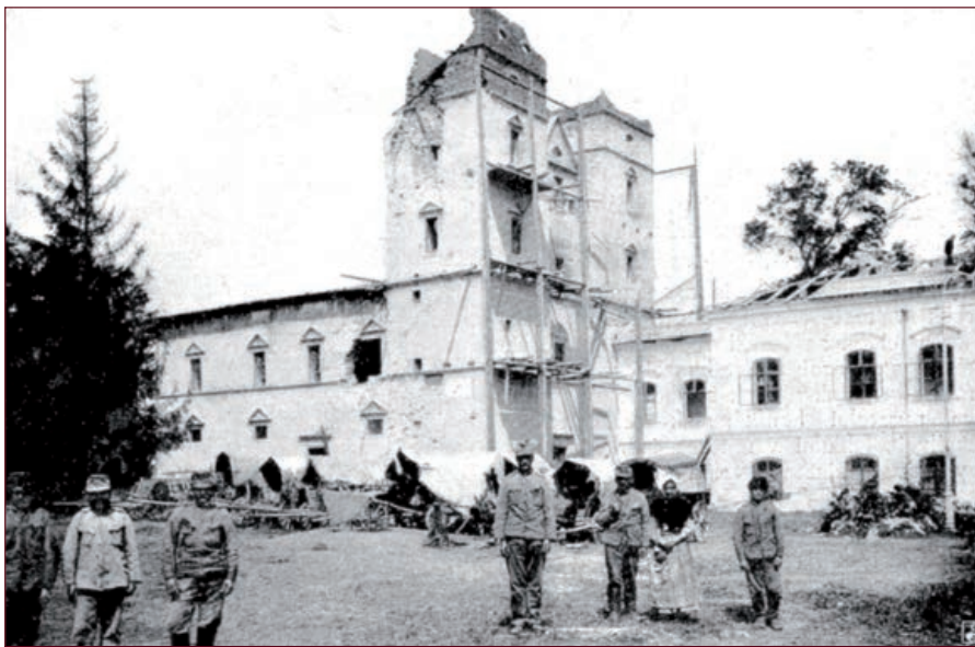
Bojmi poškodený kaštieľ v Zborove
