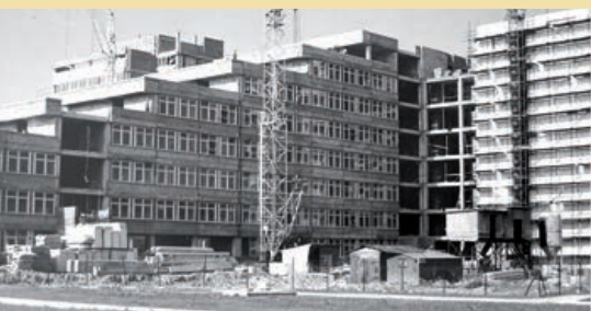
Výstavba nového areálu školy v Demänovej
