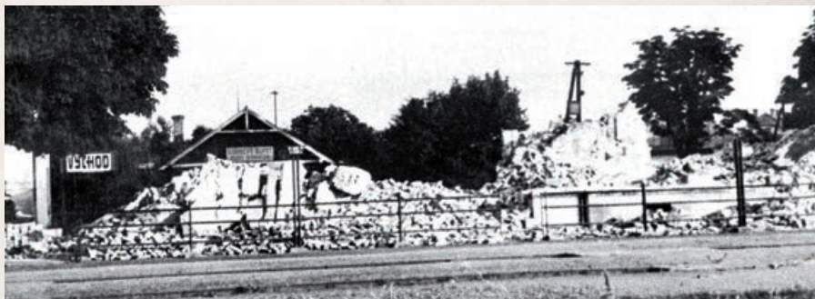
Zničená železničná stanica v Trebišove po prechode frontu
