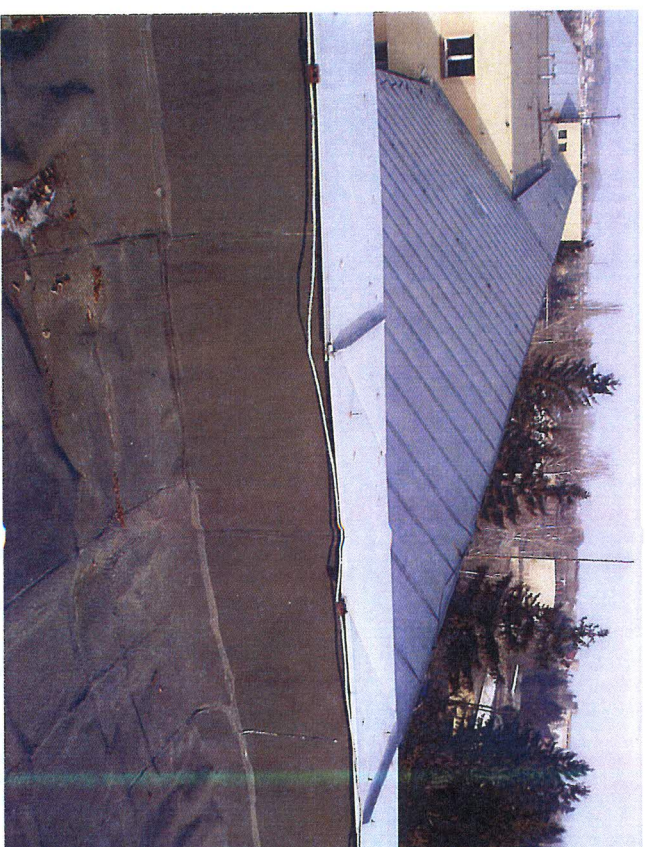
Pohľad na deformovanú strešnú krytinu a uvoľnené upevňovacie klince
