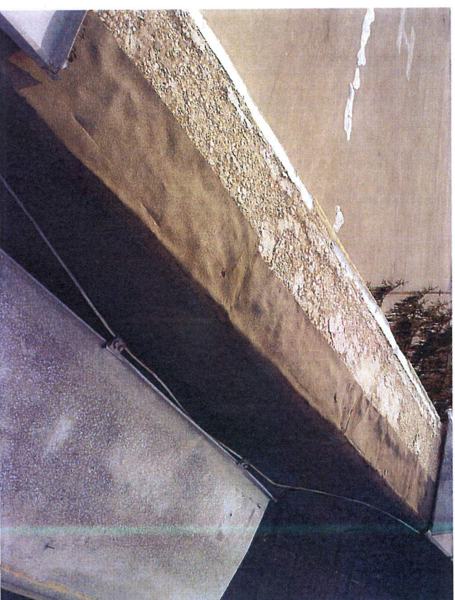
Poškodené, uvoľnené oplechovanie atíky, ktoré drží uzemňovací vodič
