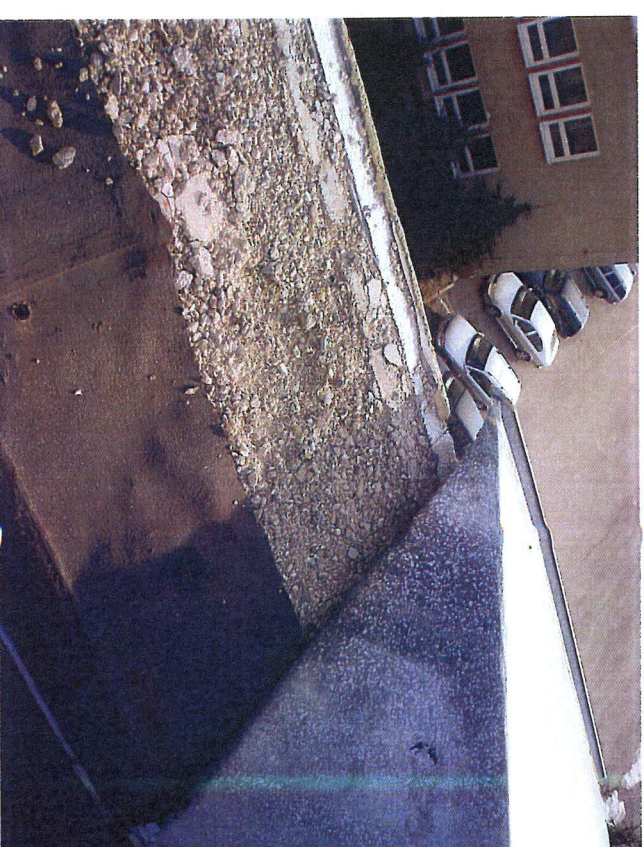
Pohľad na deformovanú strešnú krytinu a uvoľnené upevňovacie klince
