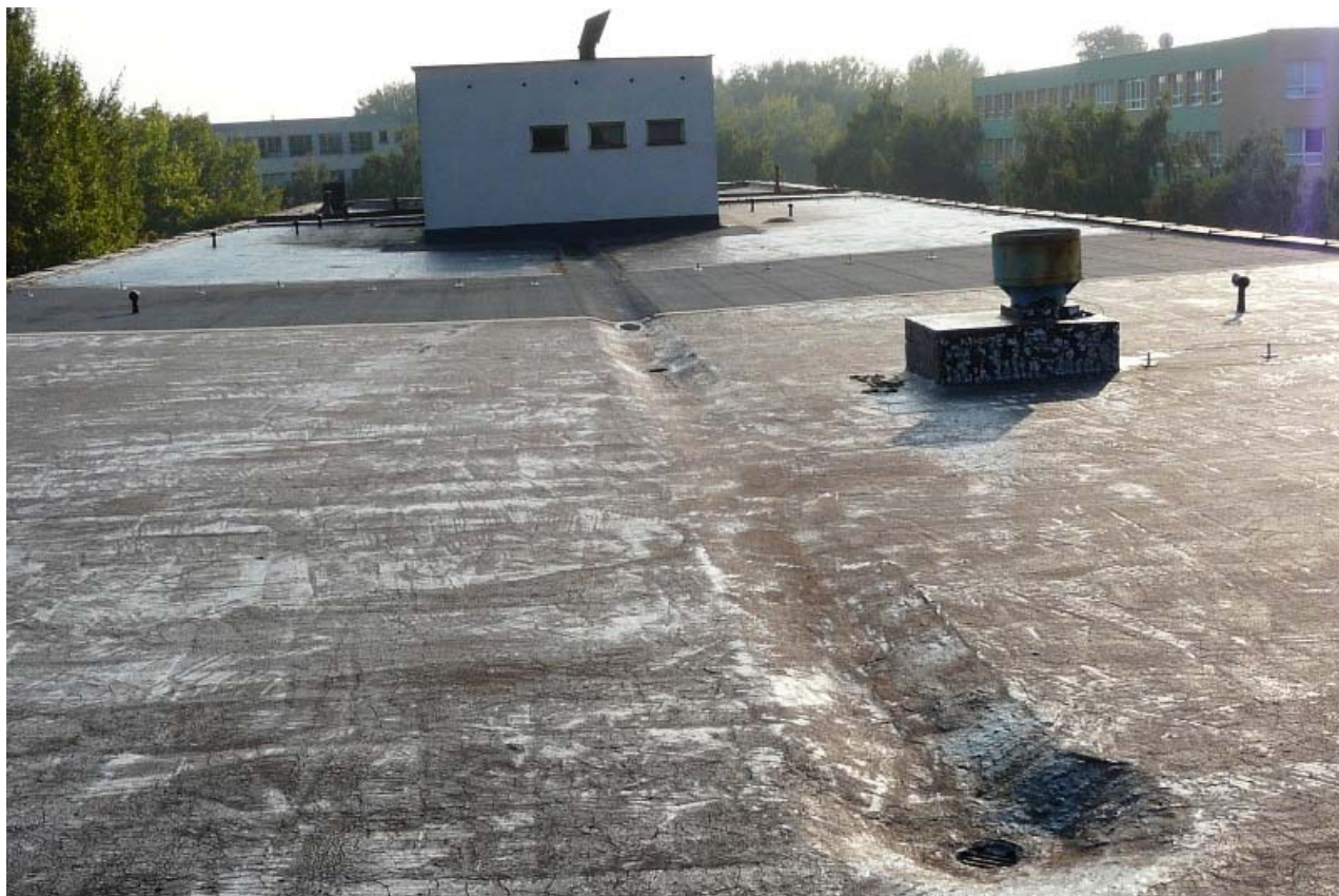
Strecha budova č. 106
