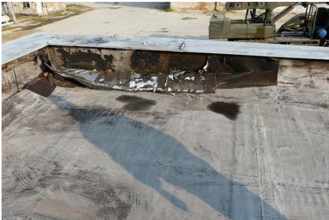
Strecha budova č. 250
