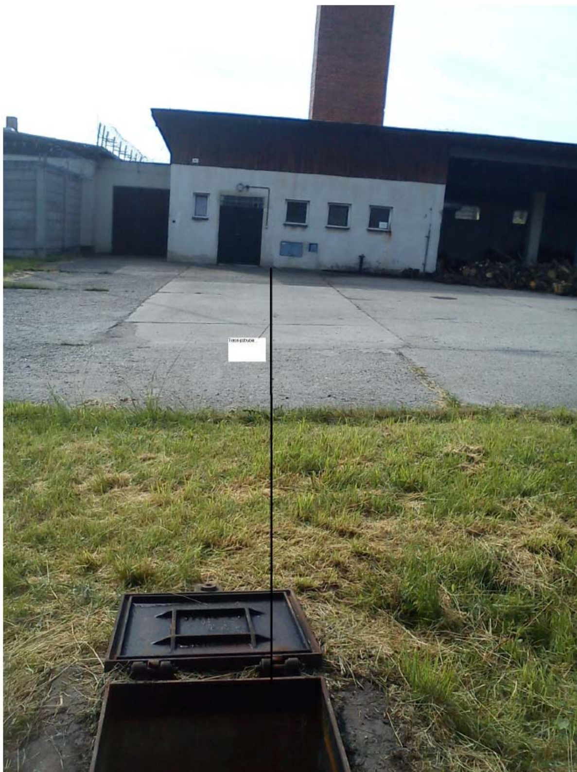
Šachta v kotolni, trasa vodovodu (čierna čiara)
