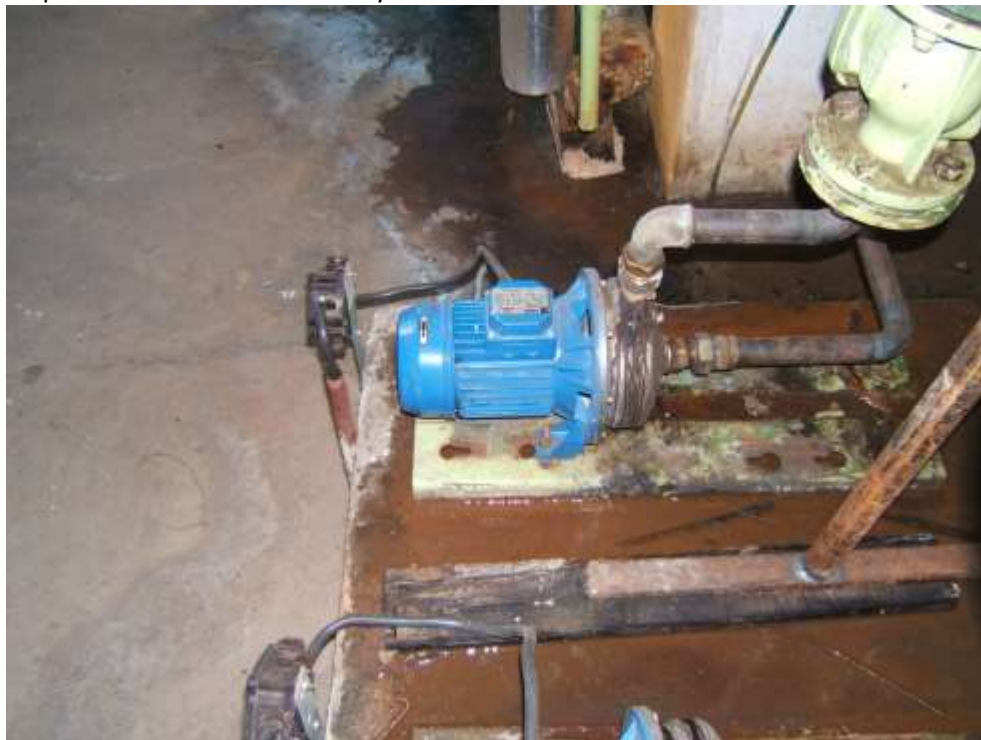
Čerpadlo kondenzu EBARA vo vým. stanici b.č. 81
