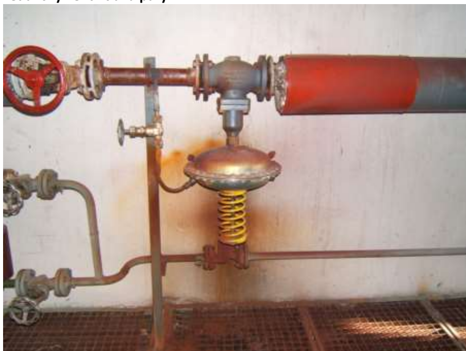
Redukčný ventil tlaku pary
