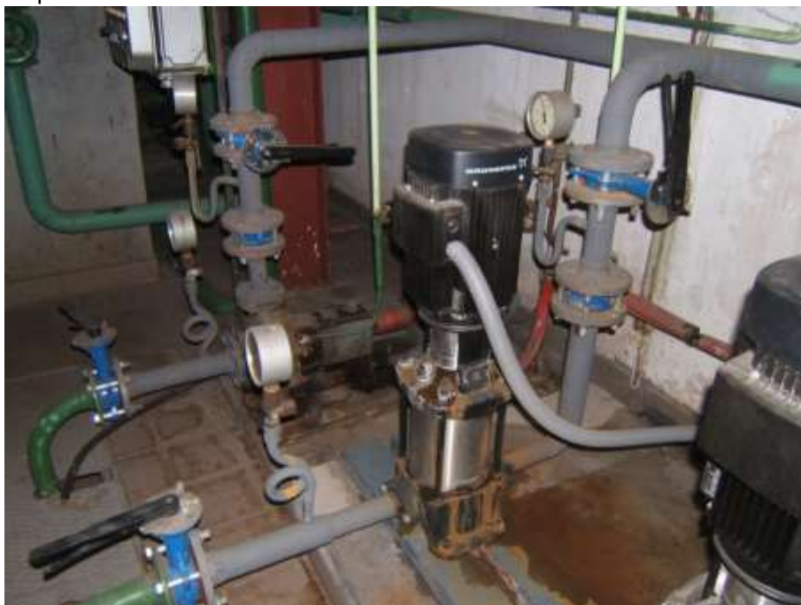
Čerpadlo kondenzu Grundfos
