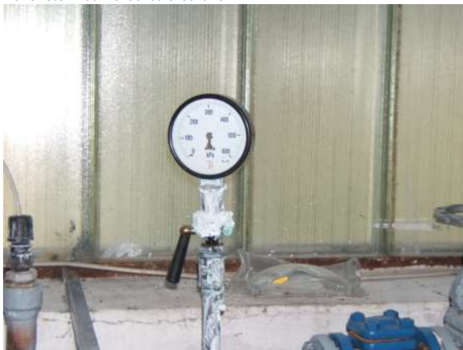
Manometer – dávkovač fosforečnanov
