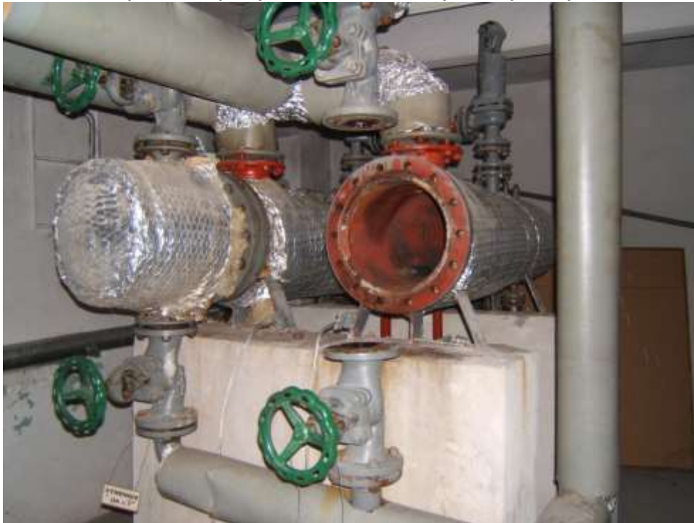
Výmenník tepla vo výmenníkovej stanici b.č. 1, Sliač kasárne predmet opravy dodanie a montáž výhrevnej vložky
