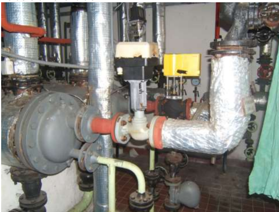
Elektroventil vo VS - b. č. 9
