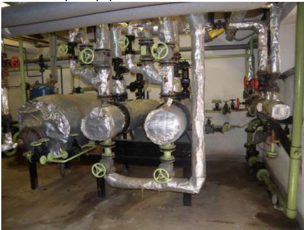
Elektroventil na prívoде pary vo VS - b. č. 22
