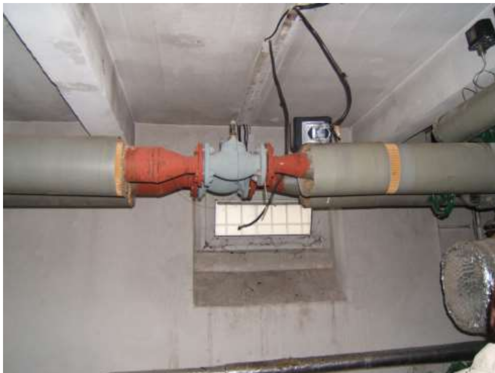
Elektroventil vo VS b.č. 1
